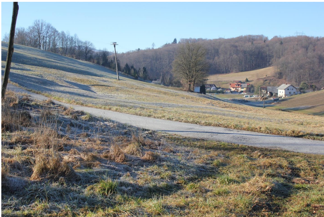
Pogled na premikajočo pobočje pod cesto, kjer se vidijo premiki in narivni robovi, posledično je premaknjen steber SNV elektra.
