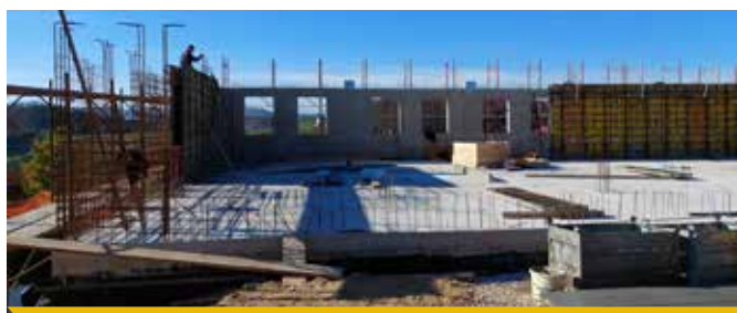
Prva faza gradnje gasilskega doma se zaključuje. Foto: arhiv občine
