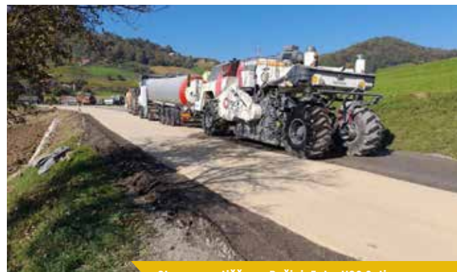
Obnova cestišča na Pečici. Foto: VOC Celje
