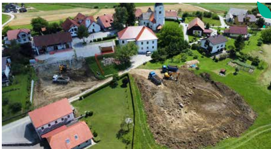
Pogled na gradbišče novega gasilskega doma na Kristan Vrhu. Foto: arhiv PGD Kristan Vrh
