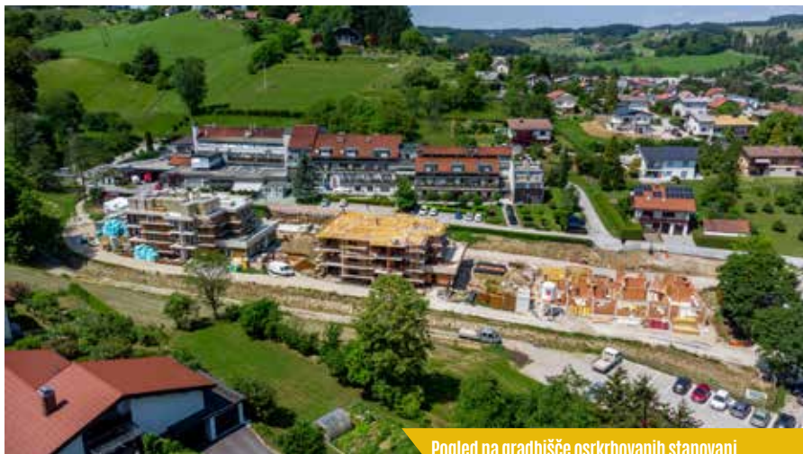
Pogled na gradbišče oskrbovanih stanovanj. Foto: Matic Javornik, Blaž Lah
