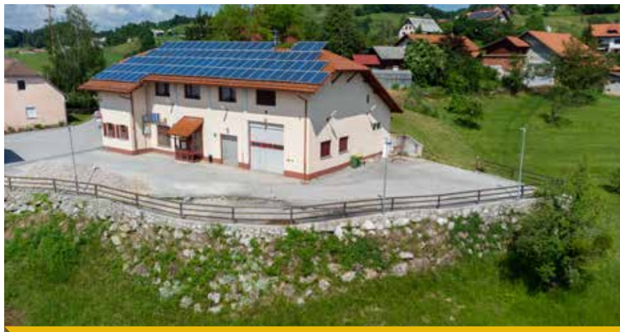
Avgusta bo končana sanacija plazu pod gasilskim domom na Sv. Štefanu. Foto: Matic Javornik, Blaž Lah
