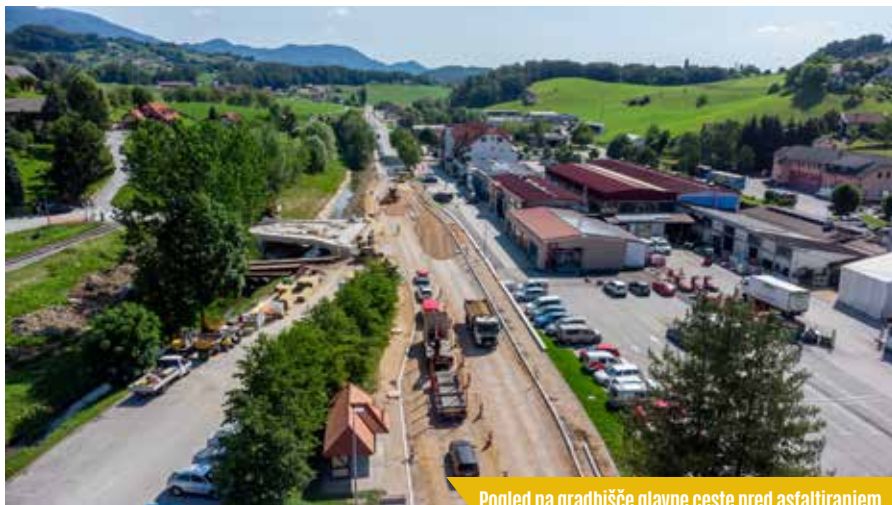
Pogled na gradbišče glavne ceste pred asfaltiranjem v začetku junija. Foto: Matic Javornik, Blaž Lah
